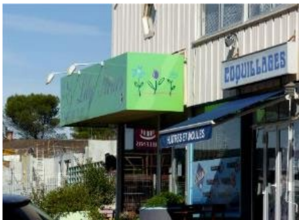
Utilité des caissons ? et spots illégaux
