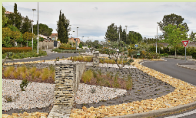
Réfection du rond-point du Pic Saint-Loup
