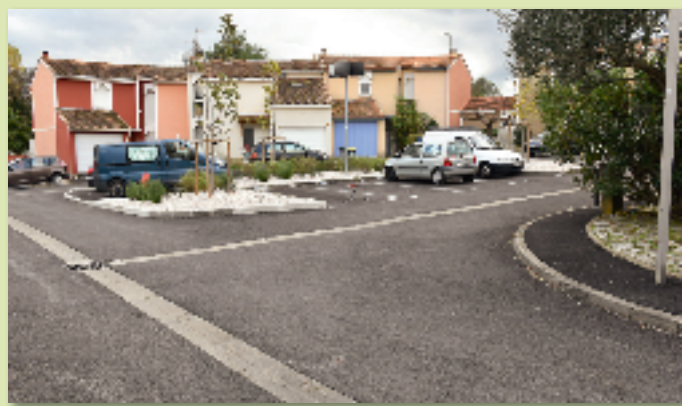
Réfection de la rue du Margal
