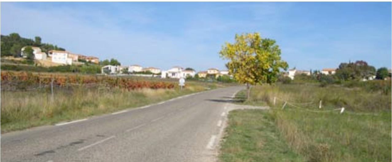
Entrée sud-ouest par la RD127E5 : les silhouettes urbaines sont fortement perçues et doivent faire l'objet de la plus grande attention.
