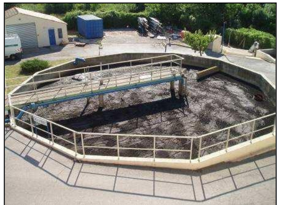
Silo à boues
